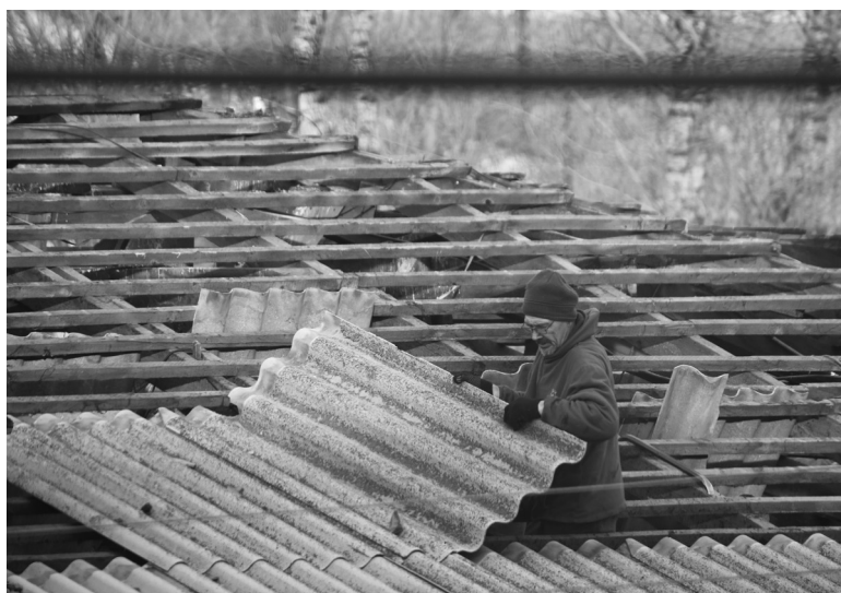
Разбор старой кровли дома по улице Щетинкина
